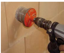
Bohrmaschine mit Bohrkrone verwenden.
