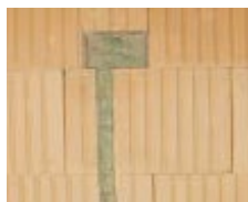
Freischlagen der gesägten/geschlitzten Bereiche mit Hammer & Meißel.
