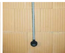
Verlegung der Elektroinstallationen.
