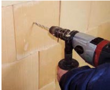
Bohrmaschine ohne Schlagwerk verwenden.
