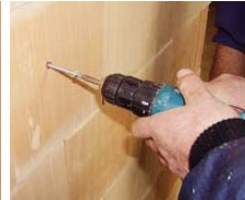
Schraube in den Dübel eindrehen.
