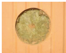
Elektrodose anzeichnen und bohren.
