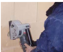
Mit der Schlitzfräse die Ziegel schlitzzen.
